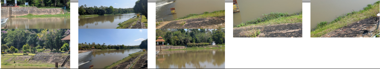
3 ส่วนควบคุม
