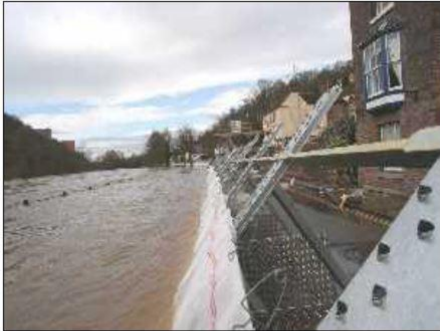
รูปที่ 4-6 ข แสดงการติดตั้งโครงสร้างแบบแผงกั้นน้ำมีโครง
